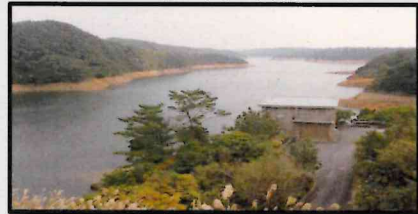
福地ダムの様子(12/31 14時) 写真:北部ダム統合管理事務所提供
